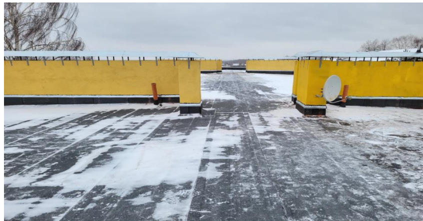
После проведения капитального ремонта
