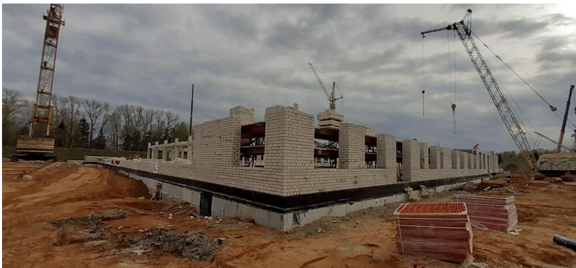
Строительство школы в п. Каравеево
