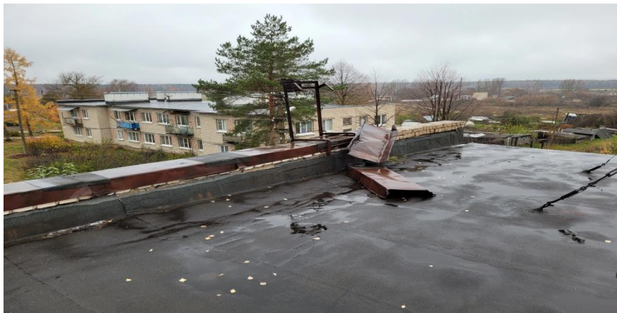
До проведения капитального ремонта
