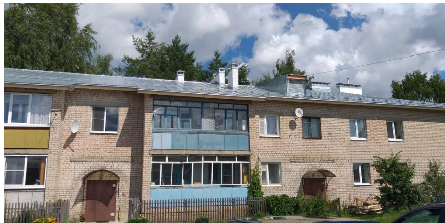
После проведения капитального ремонта
