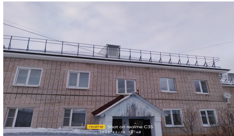
После проведения капитального ремонта
