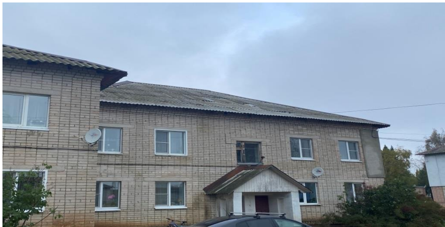
До проведения капитального ремонта
