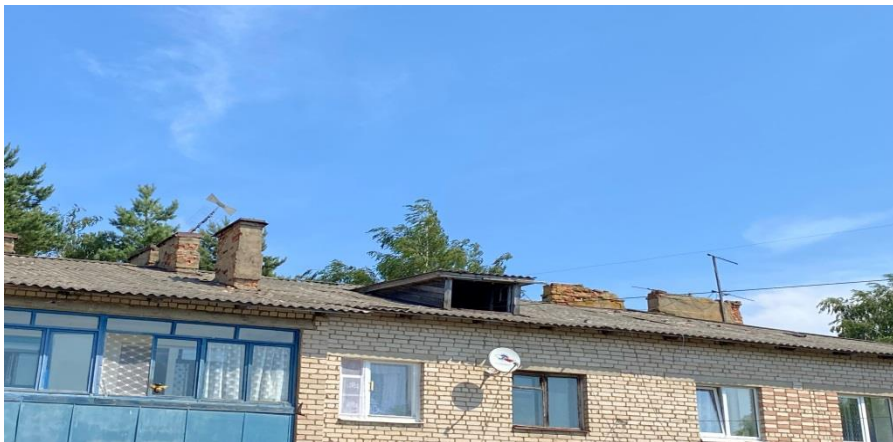
До проведения капитального ремонта
