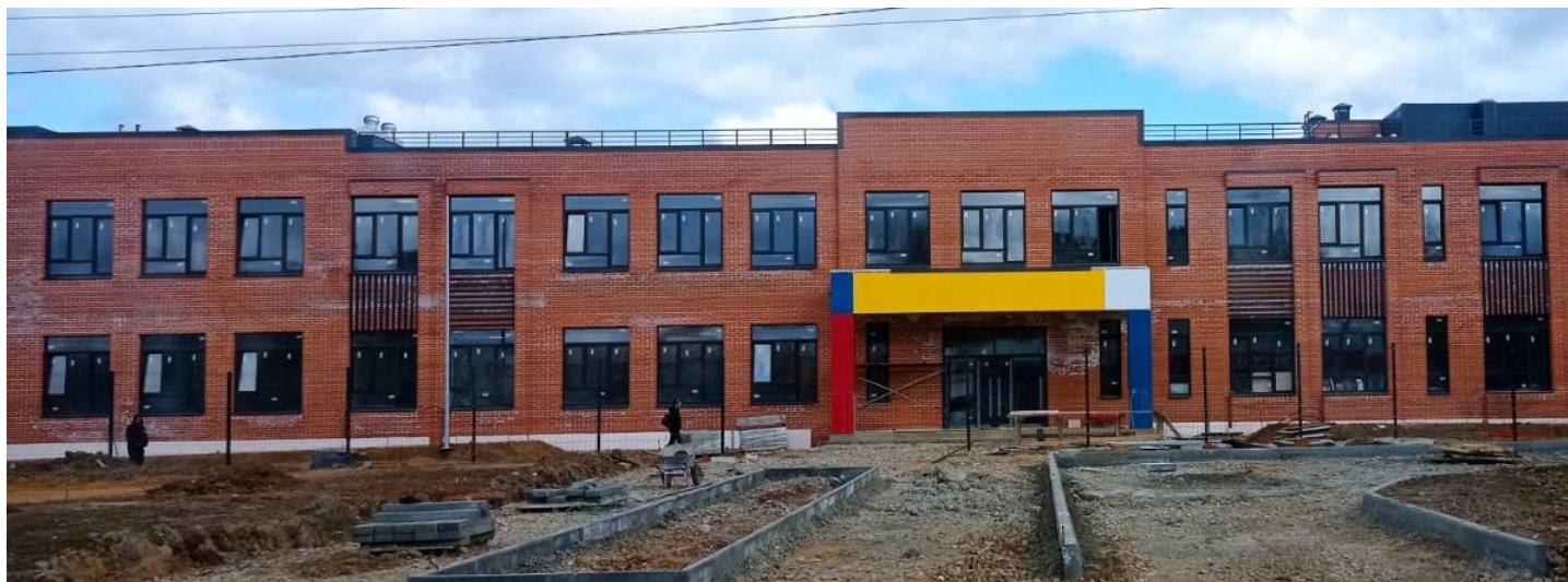
Строительство школы в п. Апраксино
